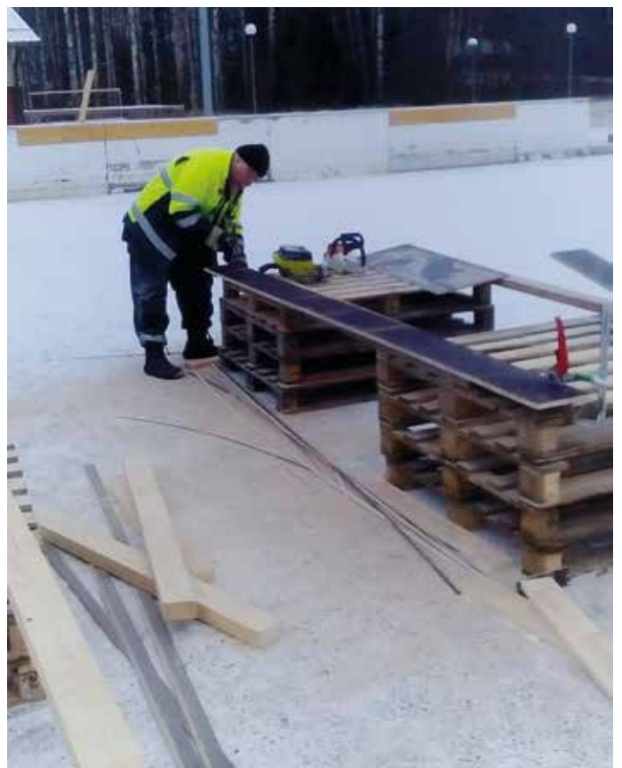
Korjasimme jääkiekkokaukalon laidat, jotta kiekko pysyy kentällä.
